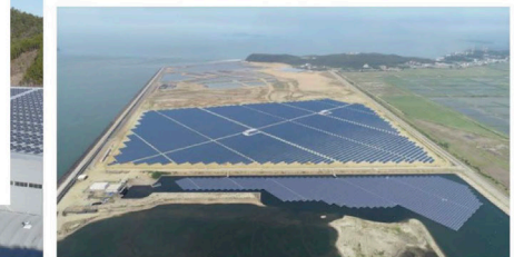
동서발전이 충남 당진화력발전소 내 유휴부지에 25MW급 태양광 발전설비를 구축했다. (사진=한국동서발전)
